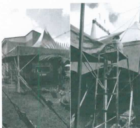
A colocação da parte superior que foi substituída e a manutenção de toda parte de estrutura com pintura e novas soldas.
